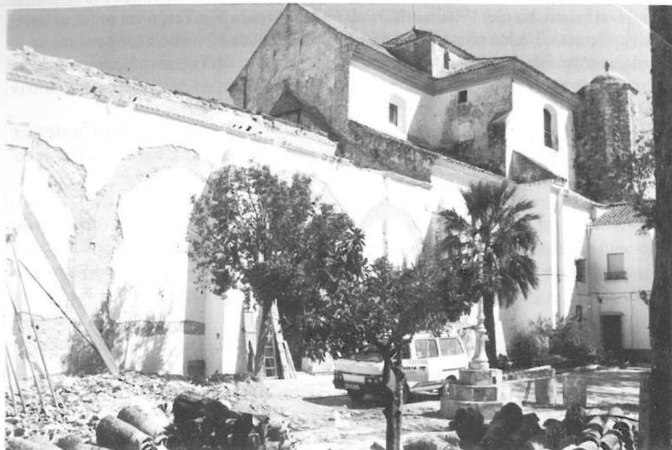
Exterior de la Parroquia durante las fases iniciales de las obras. La fachada picada deja al descubierto los arcos laterales y el tejado desmontado permite ver la cara oculta de las bóvedas
