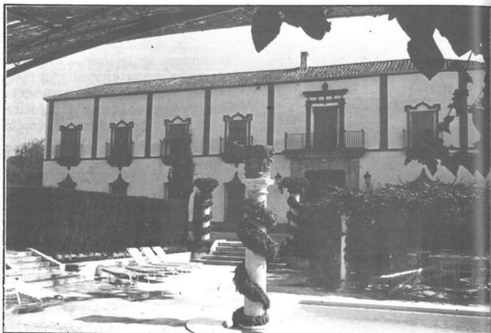
Casa-Palacio "El Rosalejo", apreciándose un trozo de los jardines que la rodean. Contigua a esta edificación se encuentra la fábrica de conservas vegetales de la Cooperativa del Campo "Pajarete"
