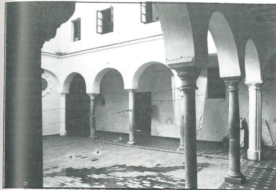
Arcadas y columnas del patio perteneciente al antiguo Convento de San Francisco, después escuelas públicas y desde ahora se encuentra la Escuela - Taller cuyos alumnos rehabilitarán el edificio, para convertirlo en la Casa de la Cultura de Villamartín ocupando toda la extensa superficie que comprenden sus edificaciones
