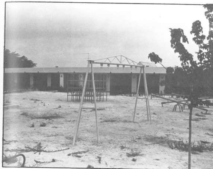
Zona de juego y recreo de la nueva Guardería Infantil "El Manantial" cuya construcción se encuentra prácticamente terminada, con cabida de 150 plazas, que funcionará el próximo curso, reuniendo todas las condiciones necesarias para atender debidamente niños, que permanecerán en ella la mayor parte del día
