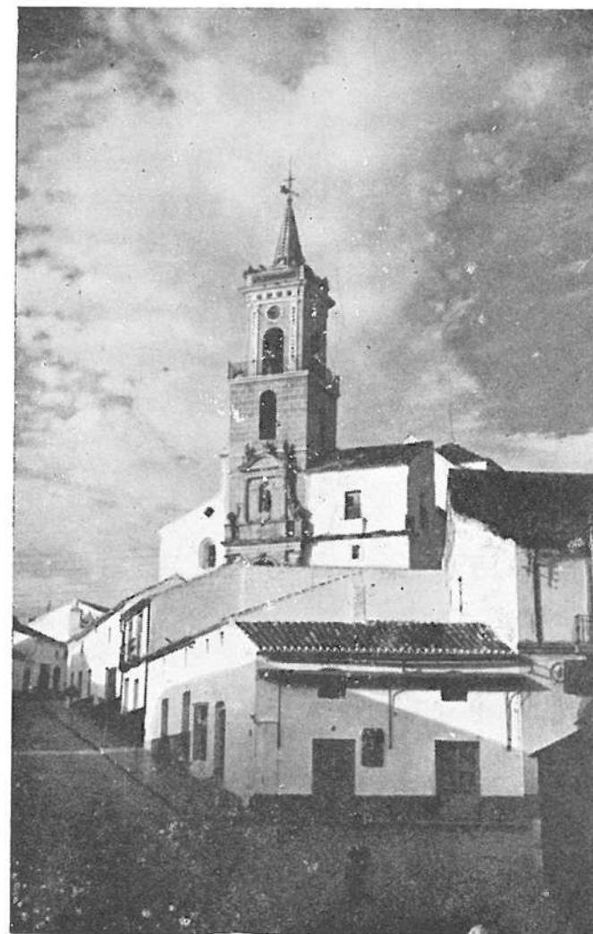
Iglesia parroquial de Santa María de las Virtudes, a la que este año se le ha hecho una reparación a fondo, de la que estaba muy necesitada.
