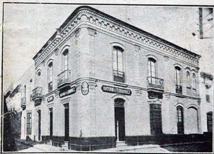
Fachada del Establecimiento
