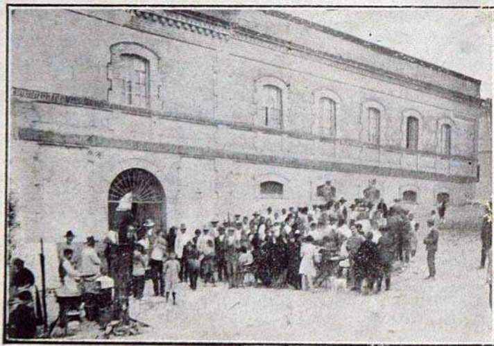
Fachada de la Plaza de Abastos
