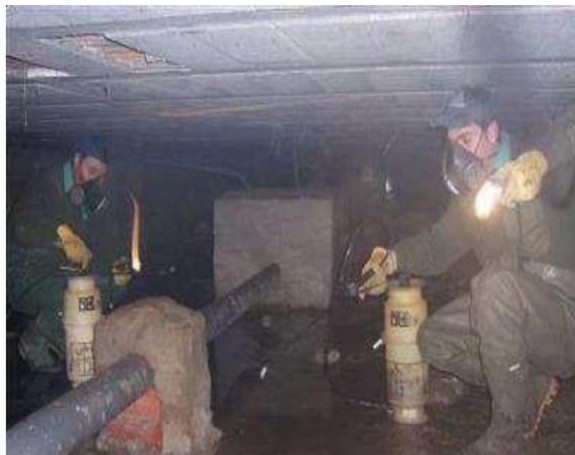
Cámara de aireación con encharcamientos de agua bajo edificio
