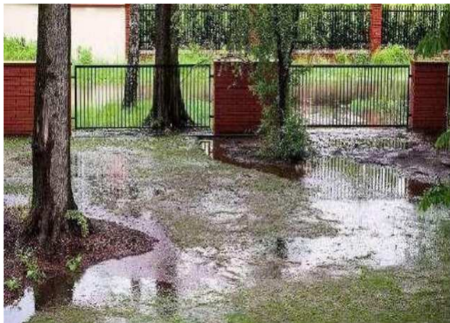
Mal drenaje de zona ajardinada
